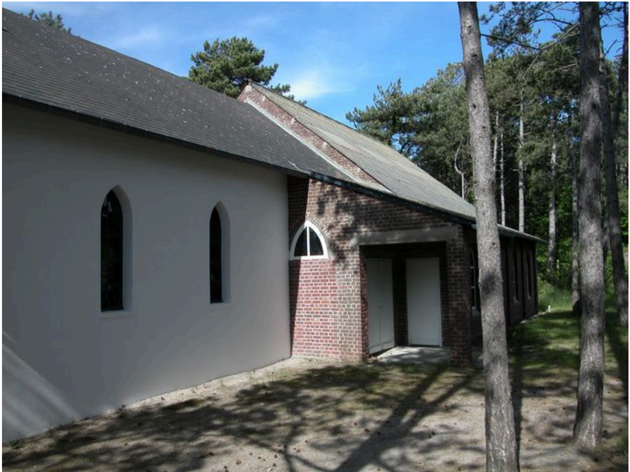
Détail de l'élévation sud.
