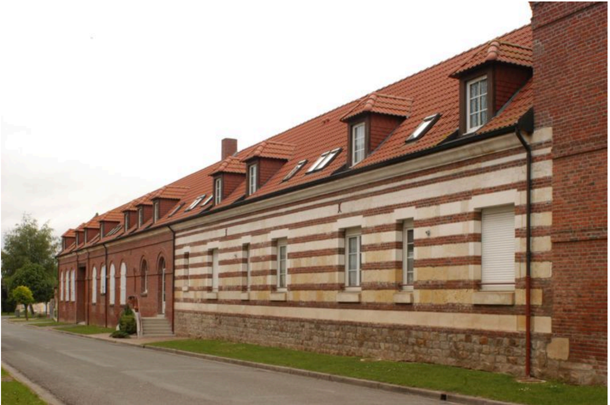
Anciennes dépendances du château : rue des Auges, vue depuis l'est.
