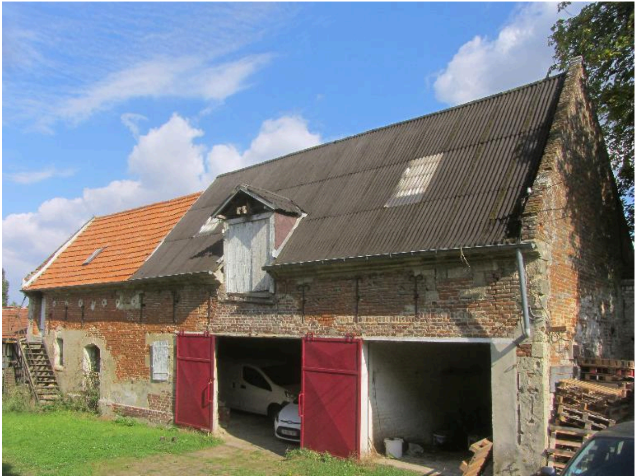
Dépendance agricole de l'ancien château, façade sur cour.
