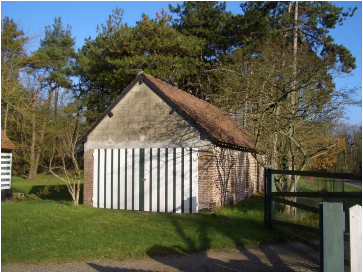
Vue du garage.
