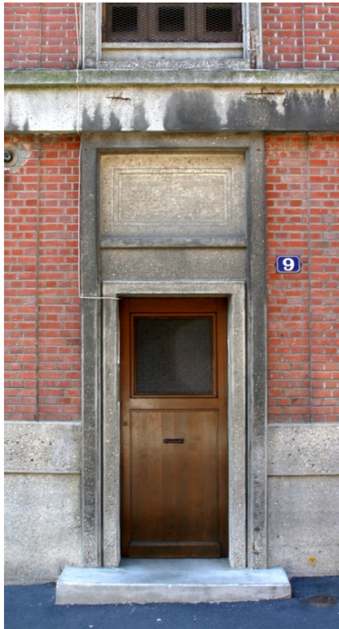
Entrée de l'immeuble d'habitation, rue de Colmar.
