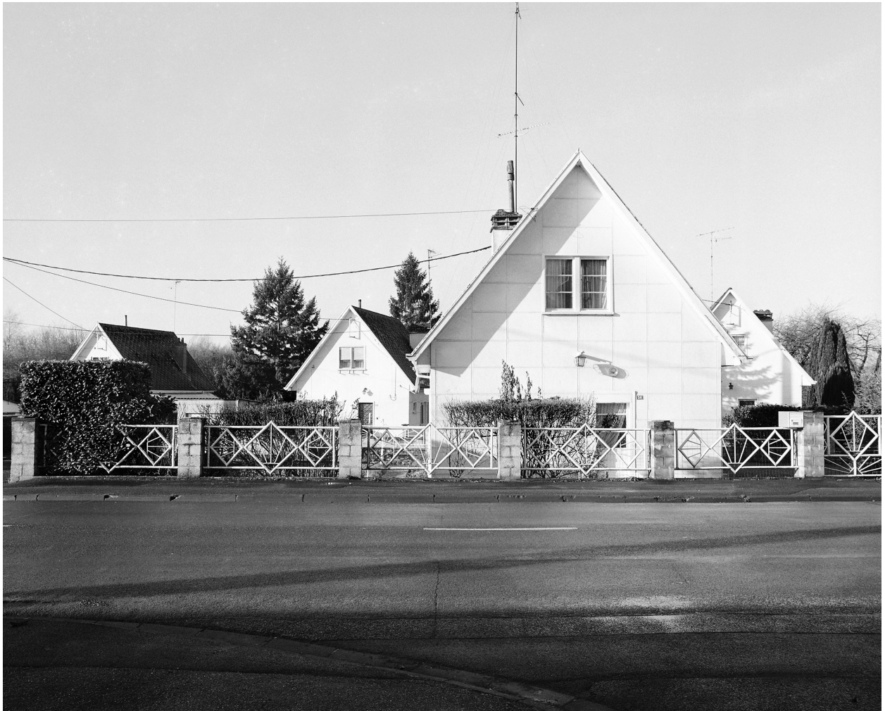
Vue générale partielle de l'ensemble.
