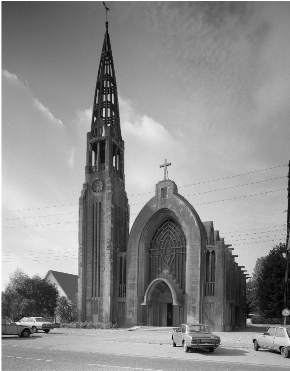
Vue générale prise du Nord Est.
