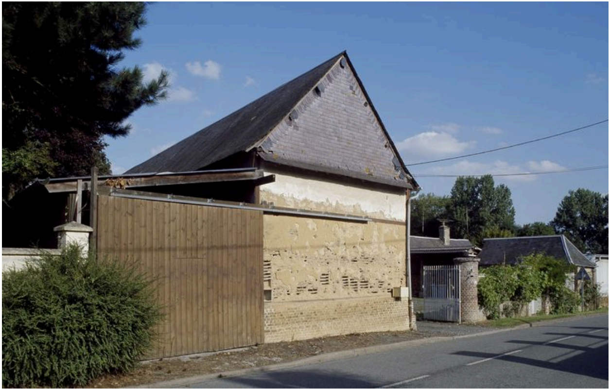
Pignon de la grange sur rue.
