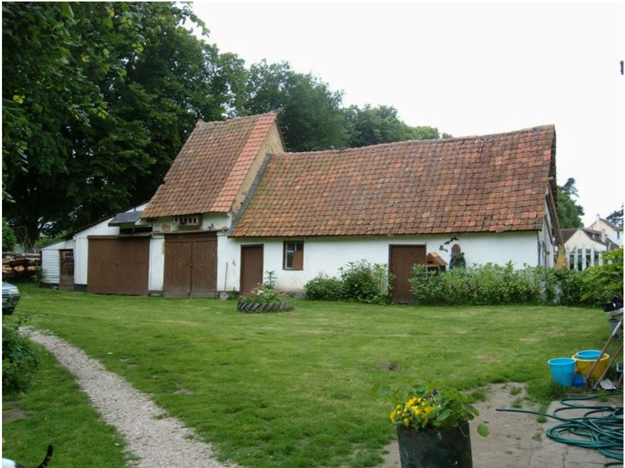
Vue du pigeonier et des anciens logements pour ouvriers.
