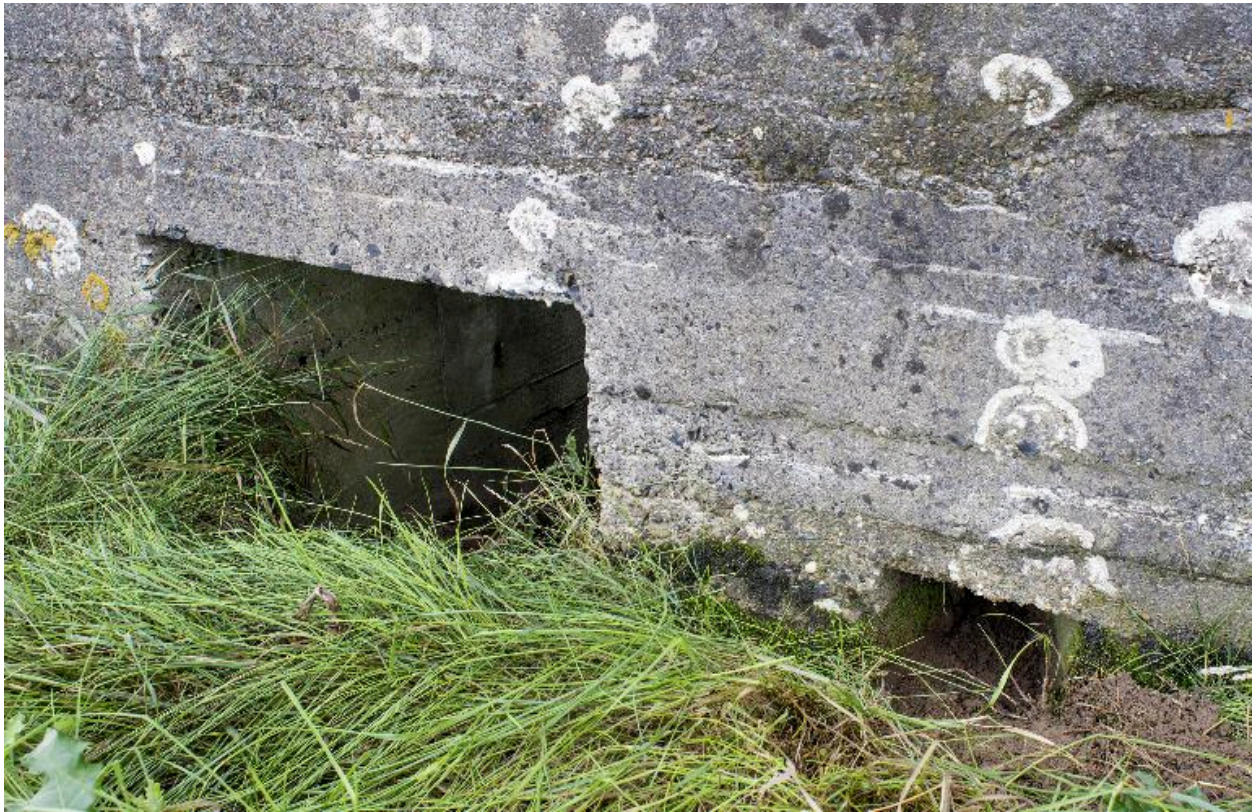
Détail de l'entrée nord. A sa droite un créneau de fusillade
