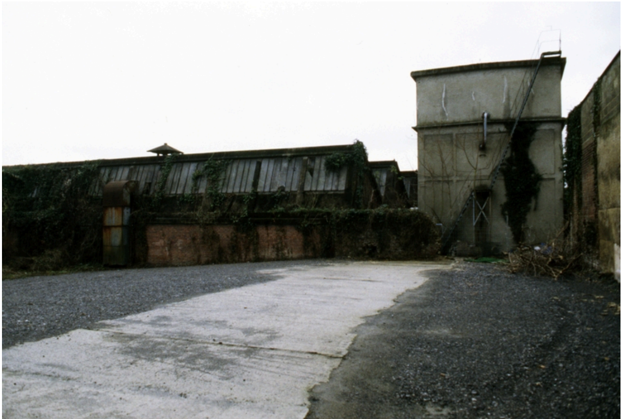
Extrémité des ateliers de la filature et le bâtiment abritant la seconde chaufferie de l'usine, 2001.
