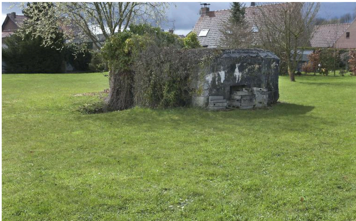
Vue générale, vers le sud
