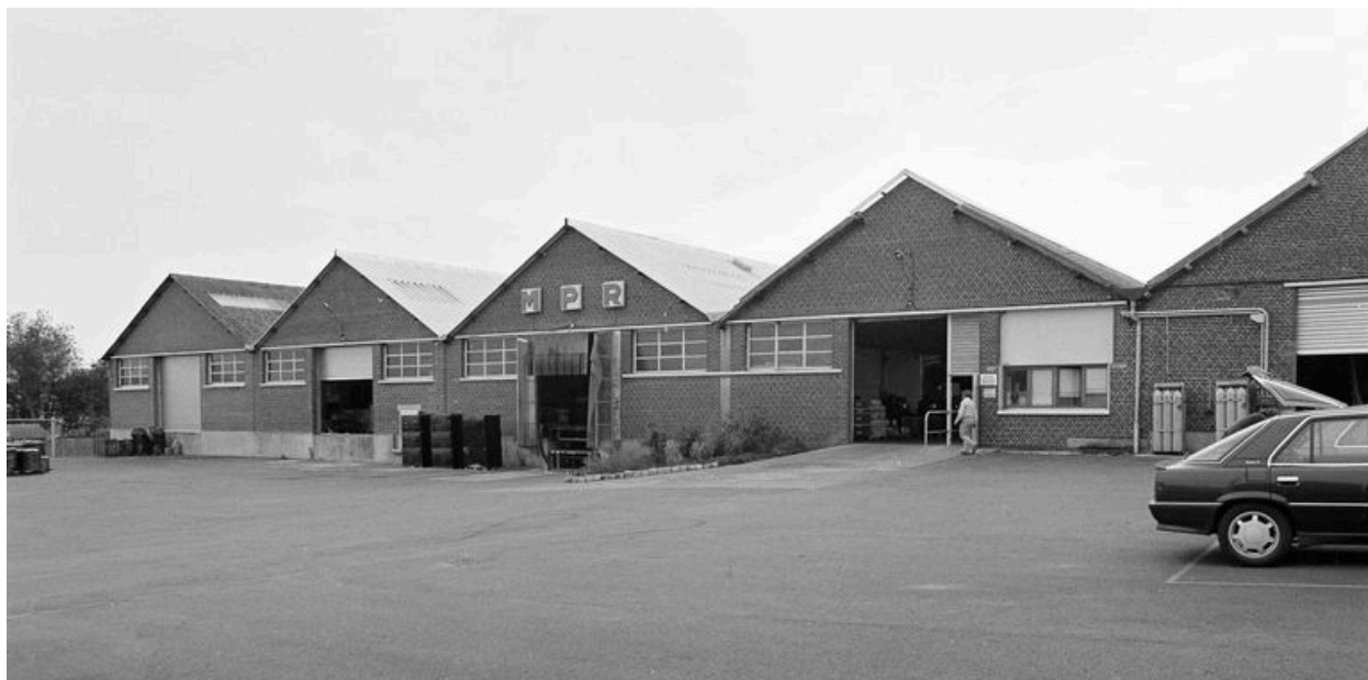
Ensemble sud des ateliers de fabrication et des magasins.
