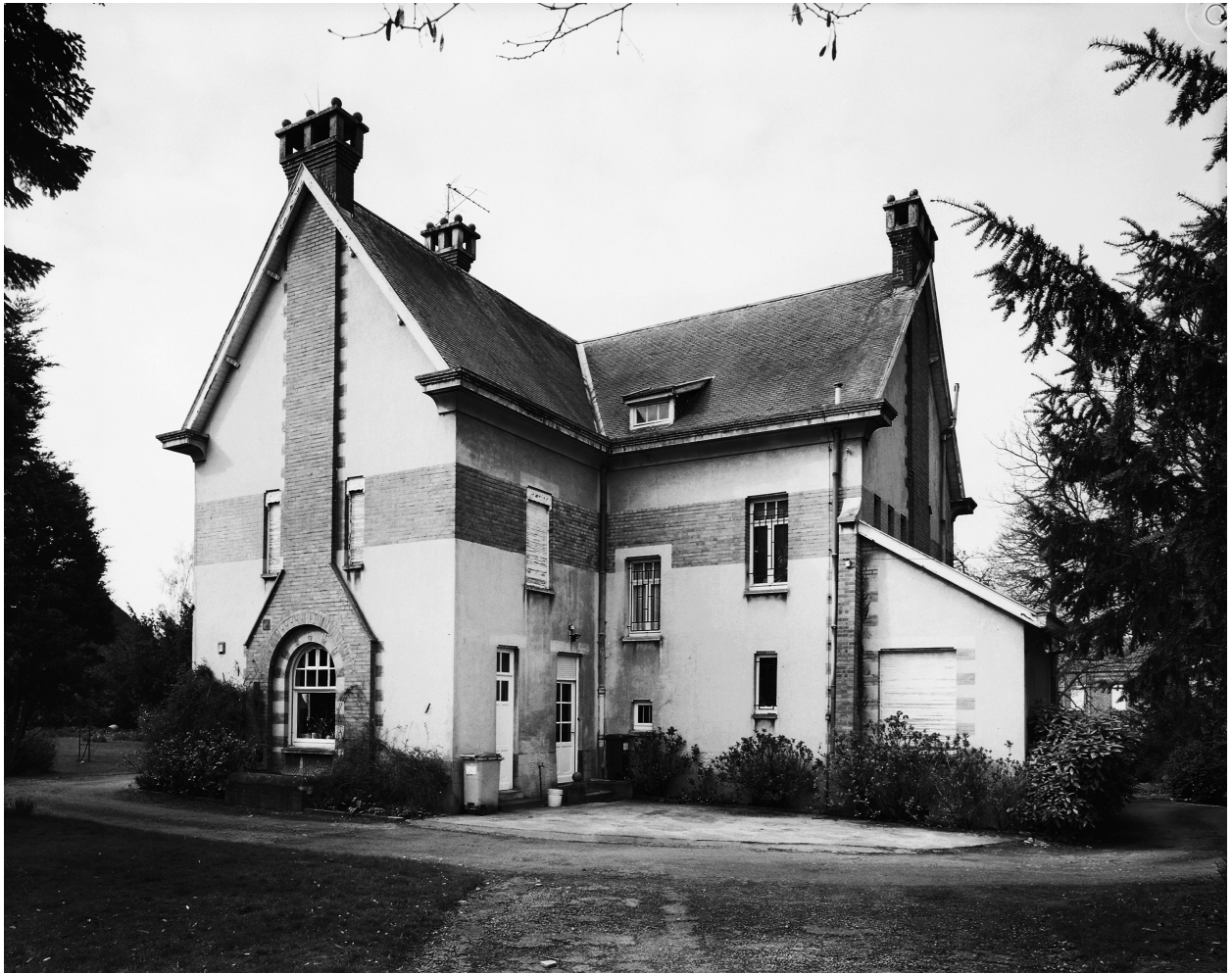
Vue générale des élévations postérieures.
