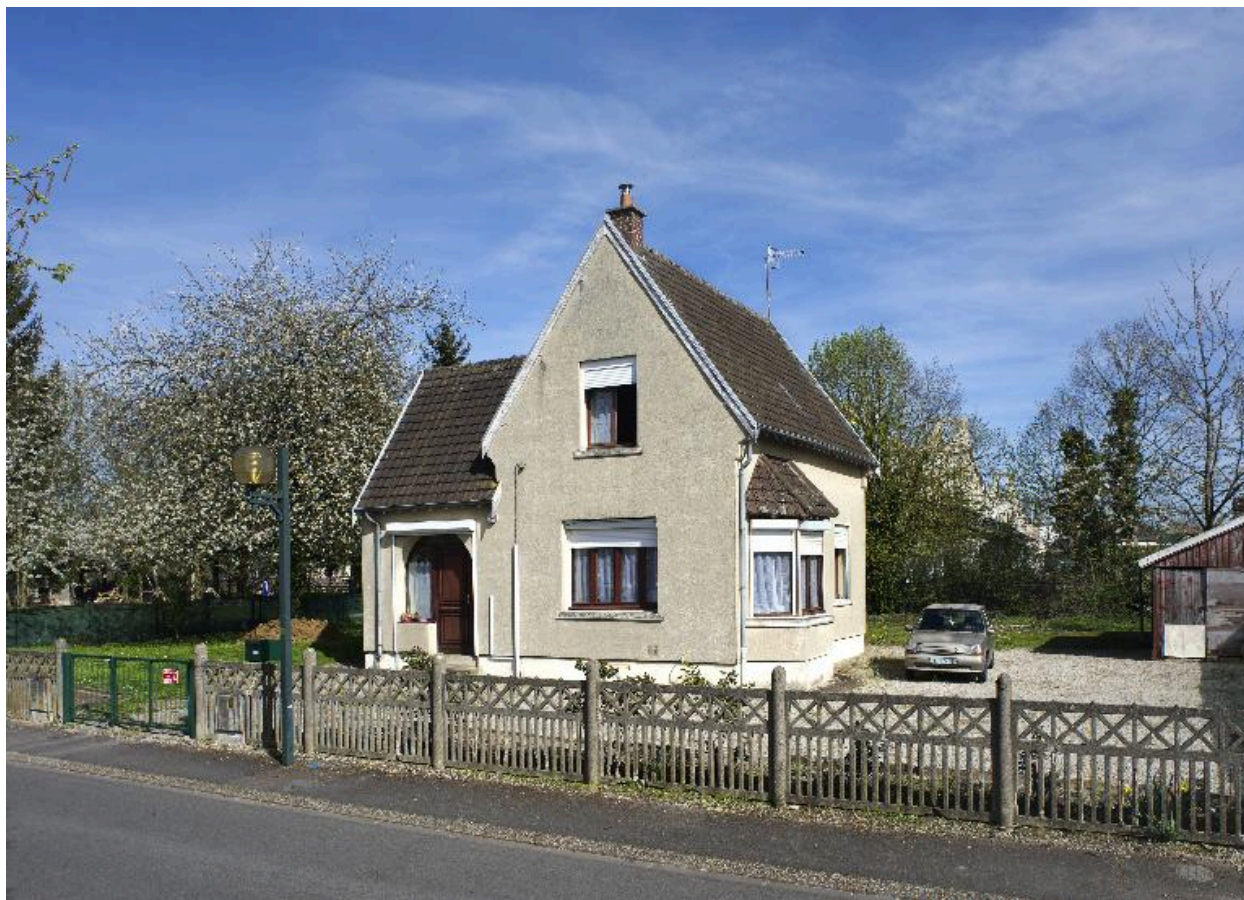
Maison, 12 place Herment. Au premier plan, la clôture d'origine.
