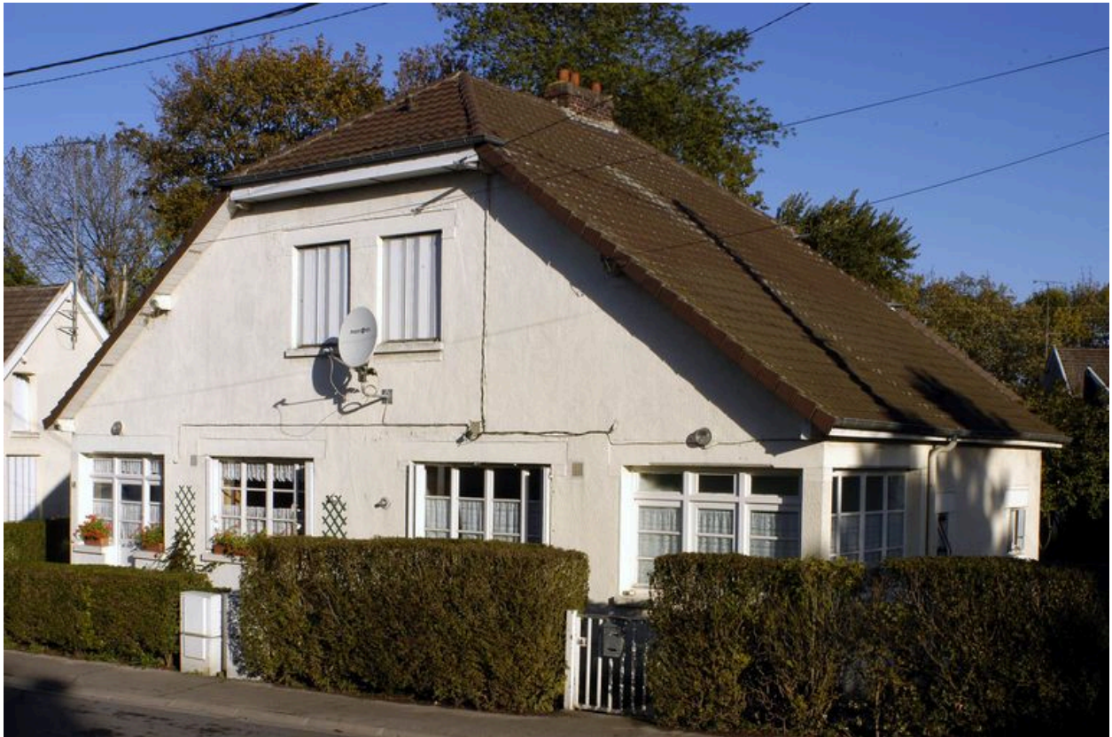
Maison, allée des Jardiniers. Vue prise en 2004 avant restauration.
