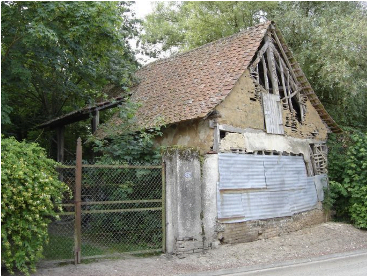
Vue générale de la charretterie.
