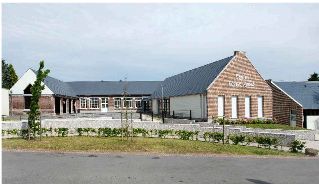
Vue d'ensemble sur rue.
