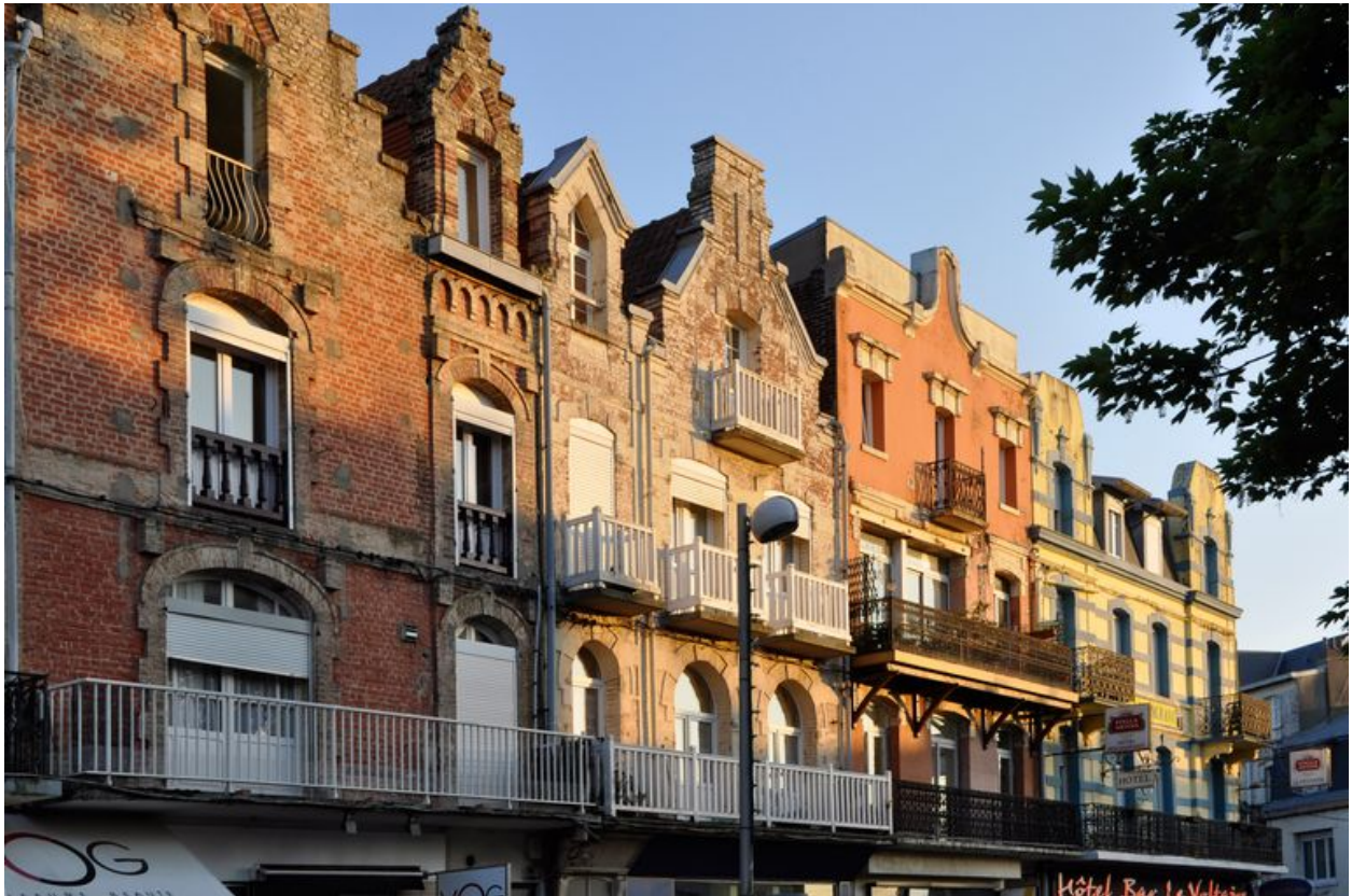
Vue générale des immeubles de l'avenue.
