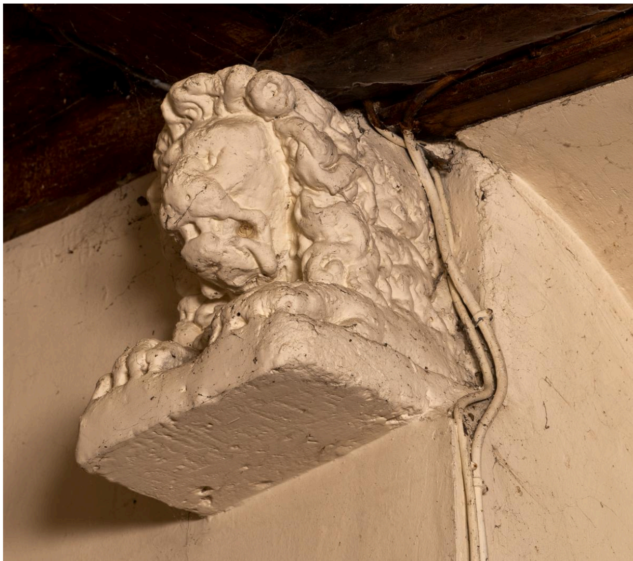
Blochet de la charpente du chœur.
