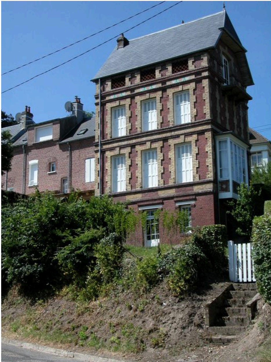
Vue d'ensemble depuis la rue du Bois de Cise.
