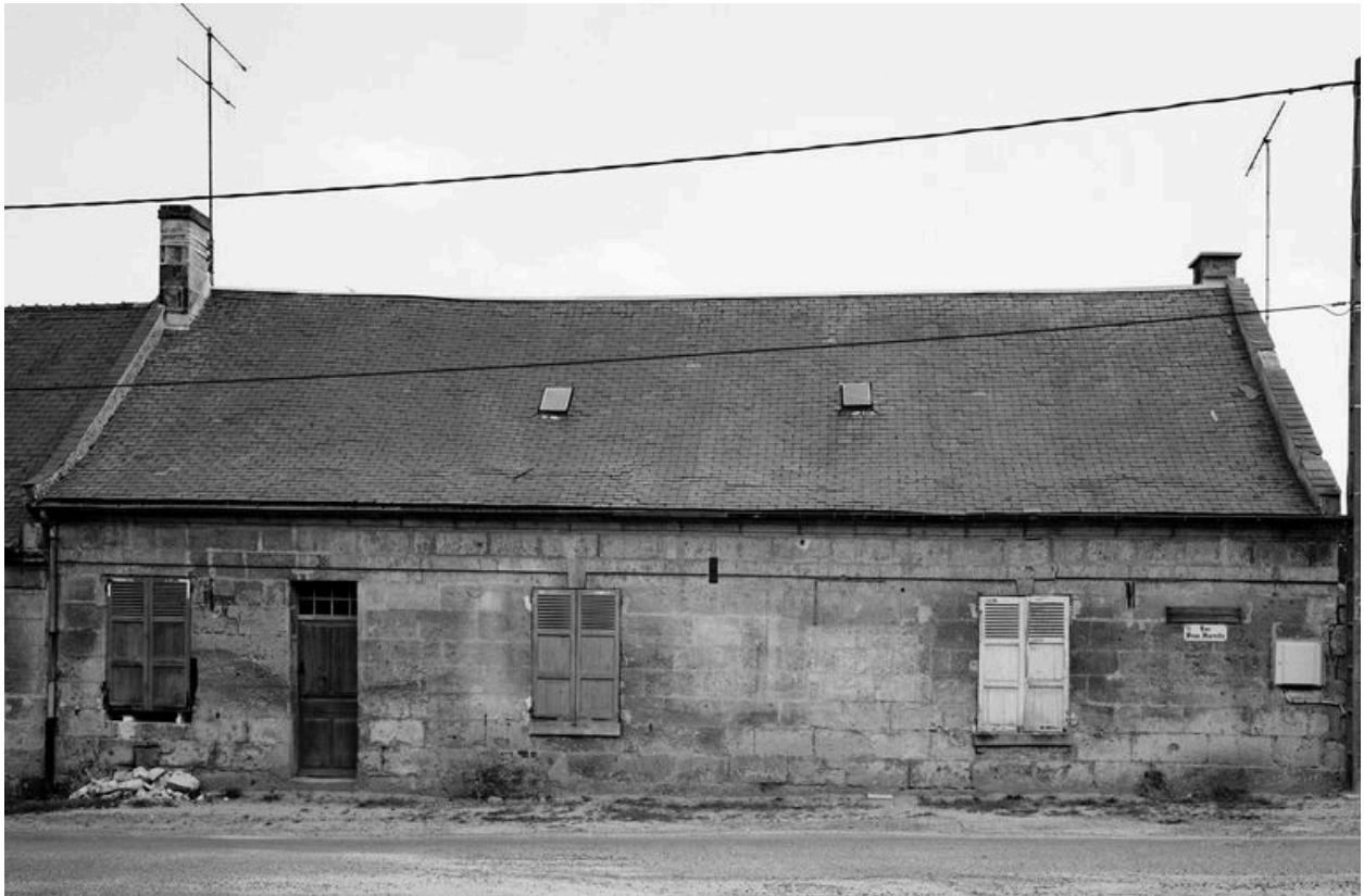
Logis. Élévation sur rue.
