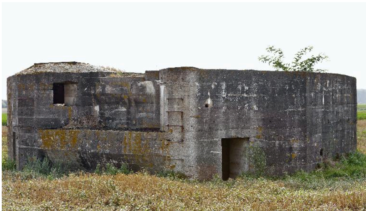
Vue de trois-quarts avant. A gauche, la tourelle d'observation, à droite, l'entrée nord
