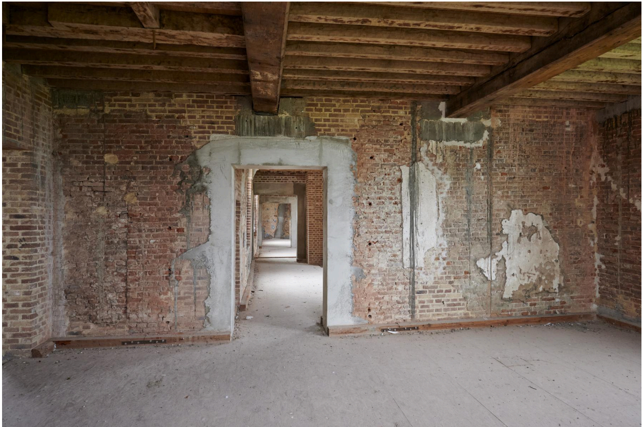
Premier étage. Logis du XVI e siècle. Chambre. Vue de l'enfilade vers le logis du XVII e siècle.
