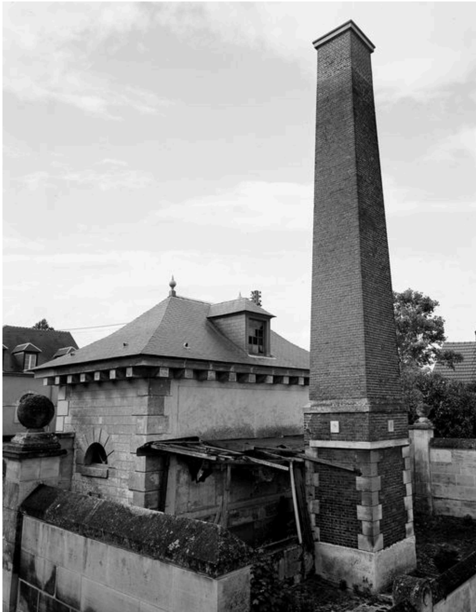
Façade postérieure : vue d'ensemble avec le bâtiment des chaudières et la cheminée.
