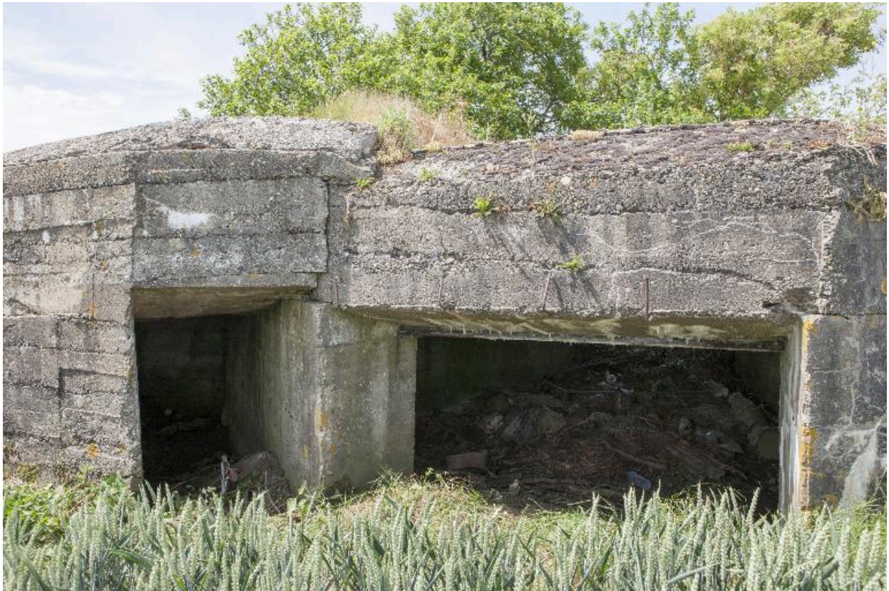
Élévation antérieure. Entrée de la chambre de tir, à droite et de la soute à munitions, à gauche
