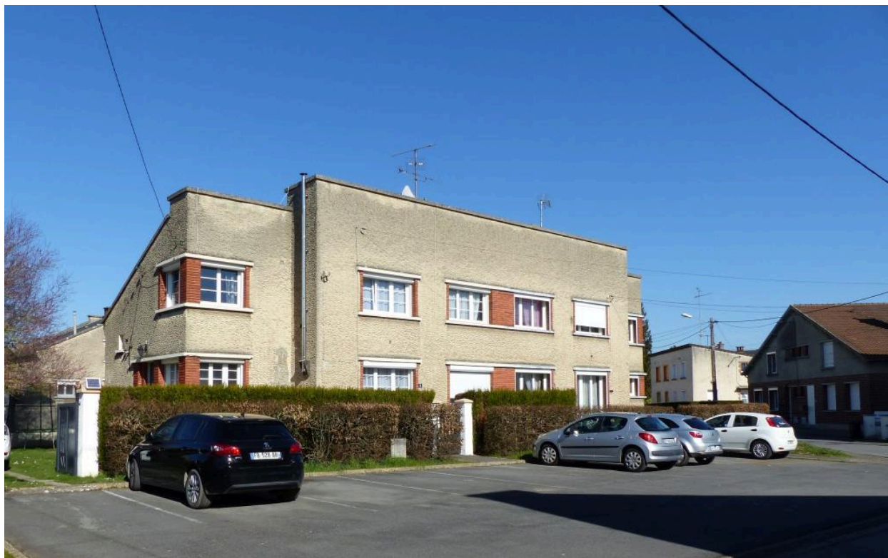
Maison à deux unités d'habitation, 2-4 rue Ernest-Lavisse.
