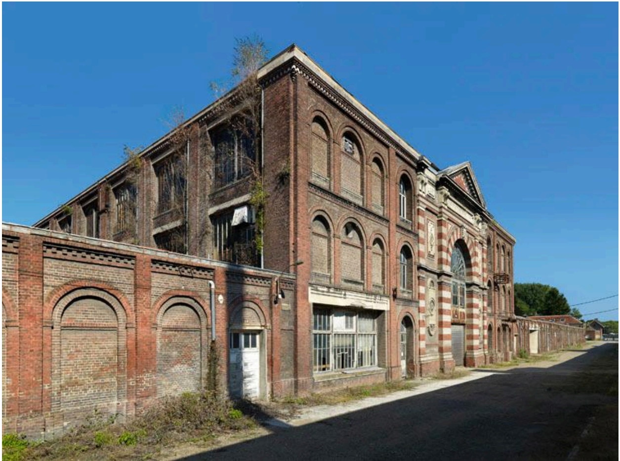
La salle des machines, vue de trois quarts.
