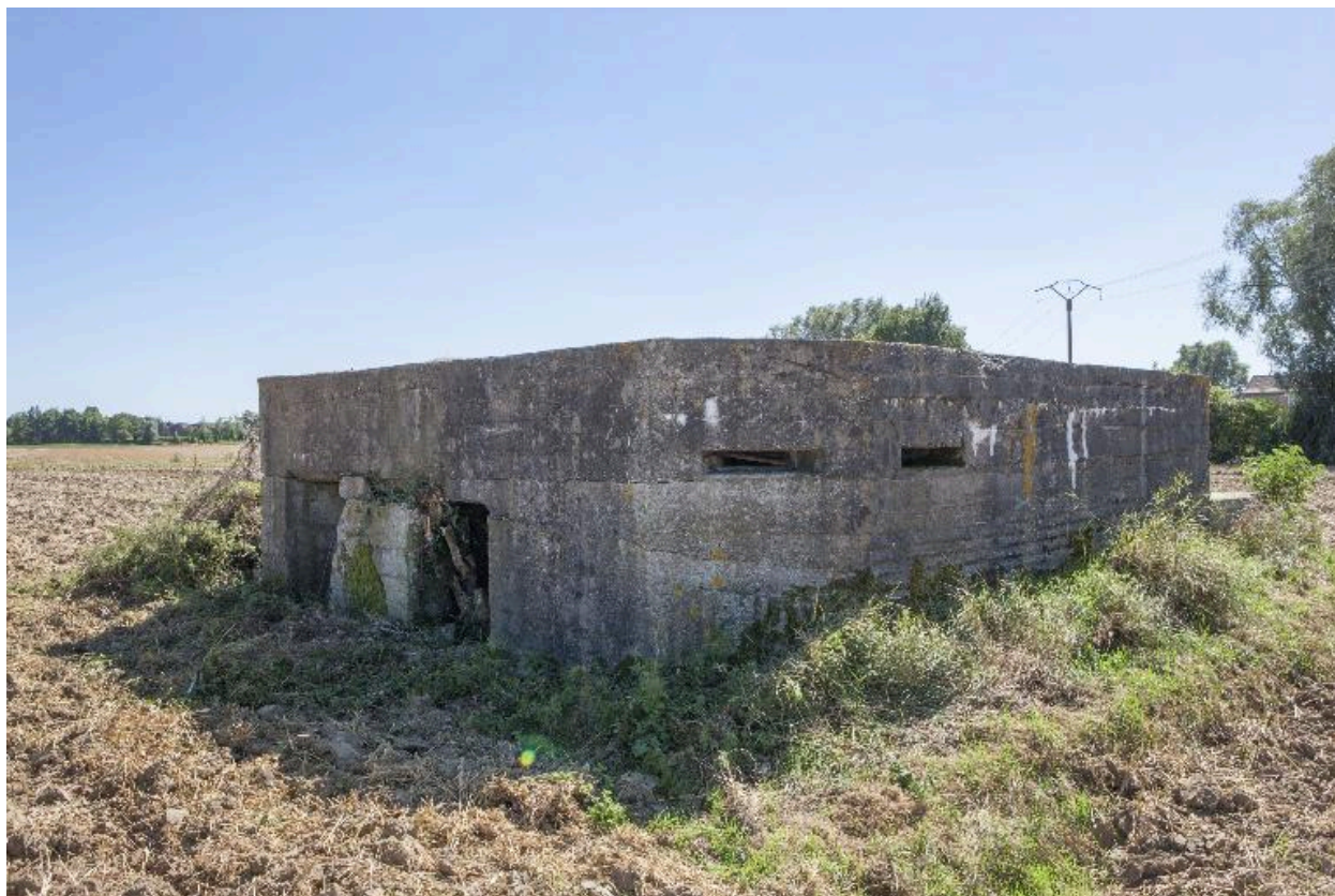
Vue de trois-quarts, vers le sud.
