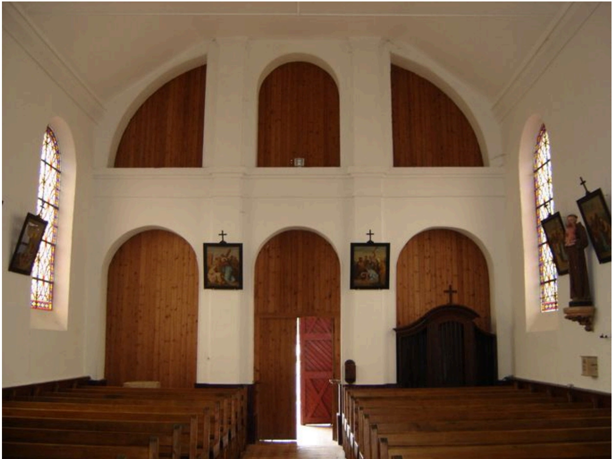
Vue intérieure du mur ouest.
