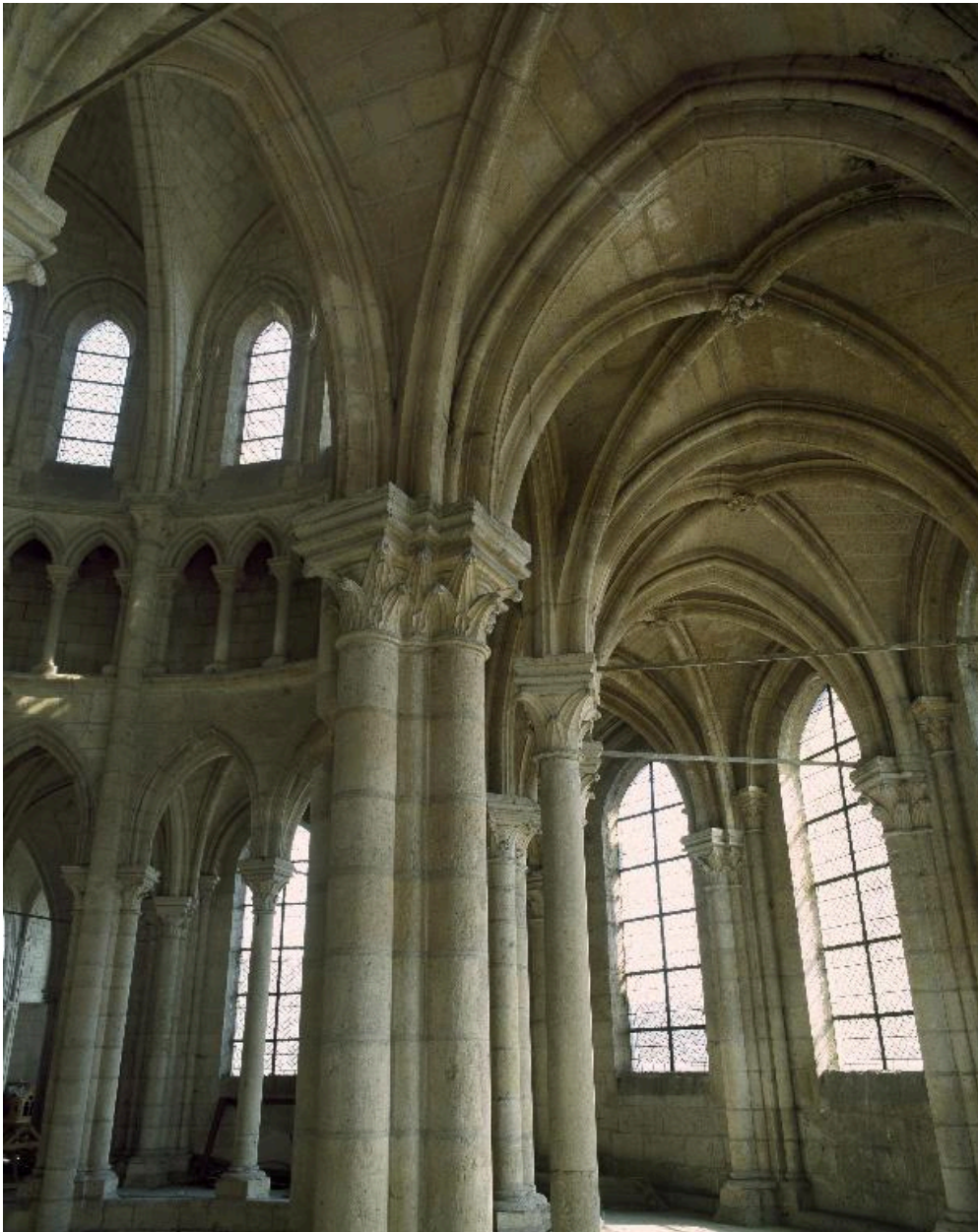
Croisillon sud du transept : vue du voûtement des tribunes.
