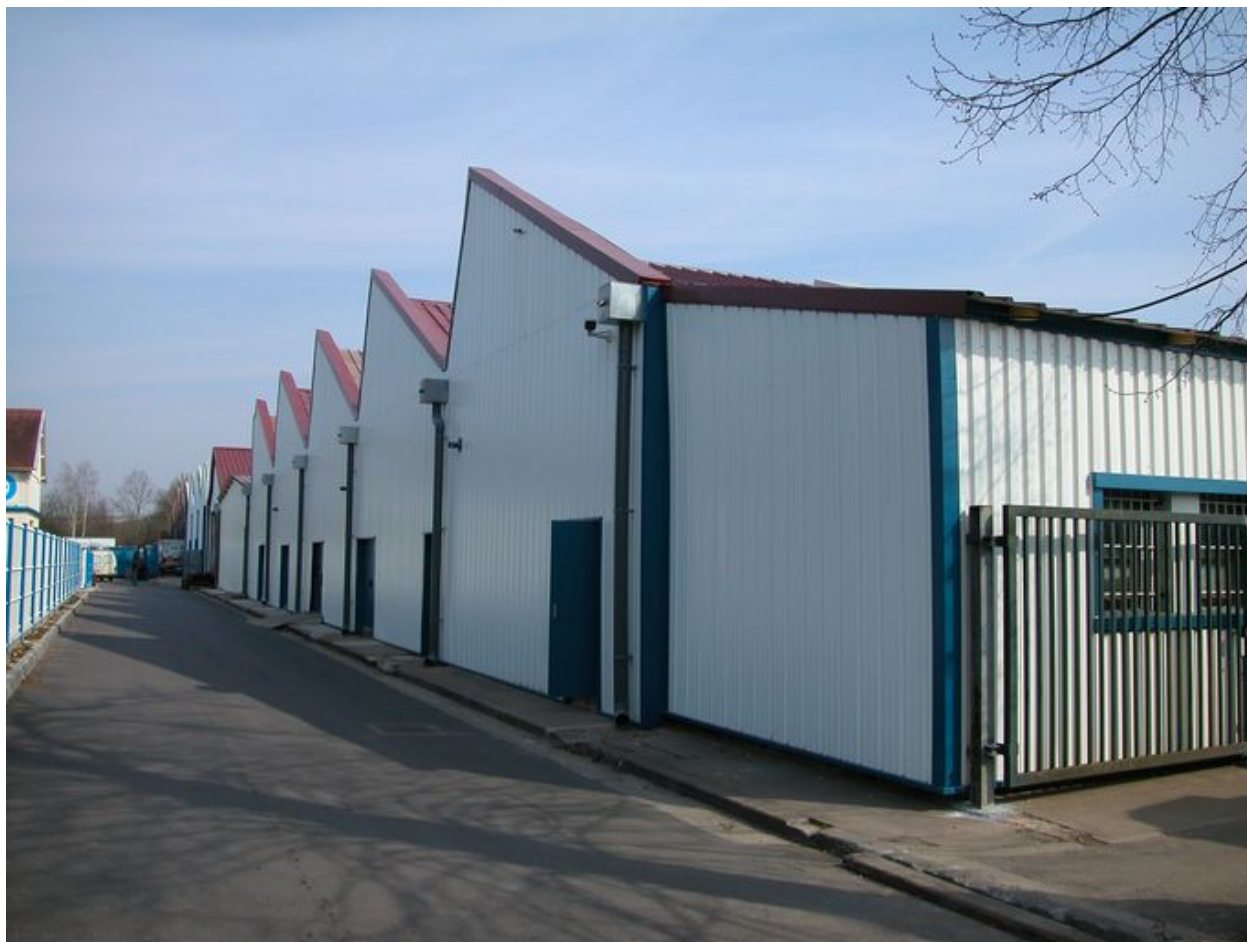
Façade ouest de l'atelier de fabrication.
