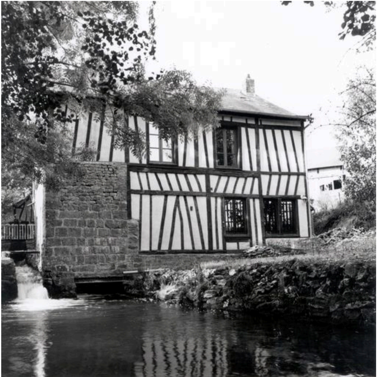
Vue d'ensemble de la façade postérieure.
