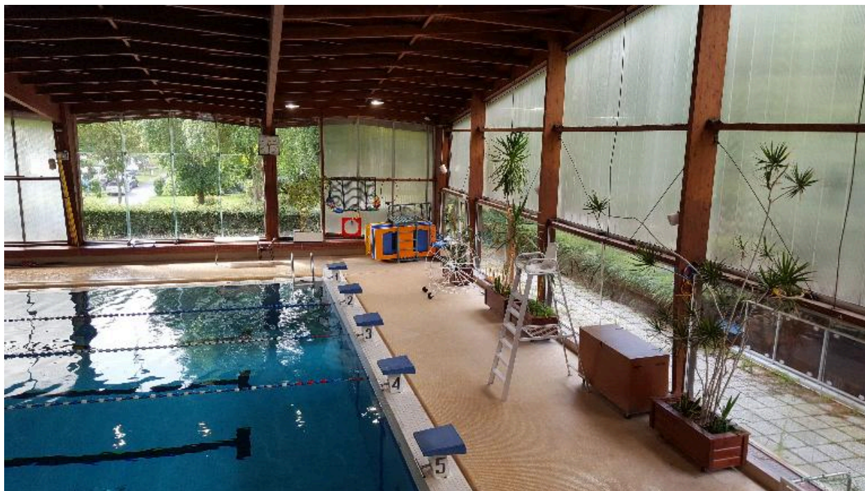
Pignon ouest (à extrémité du bassin sportif avec départs des plots des lignes de nage).
