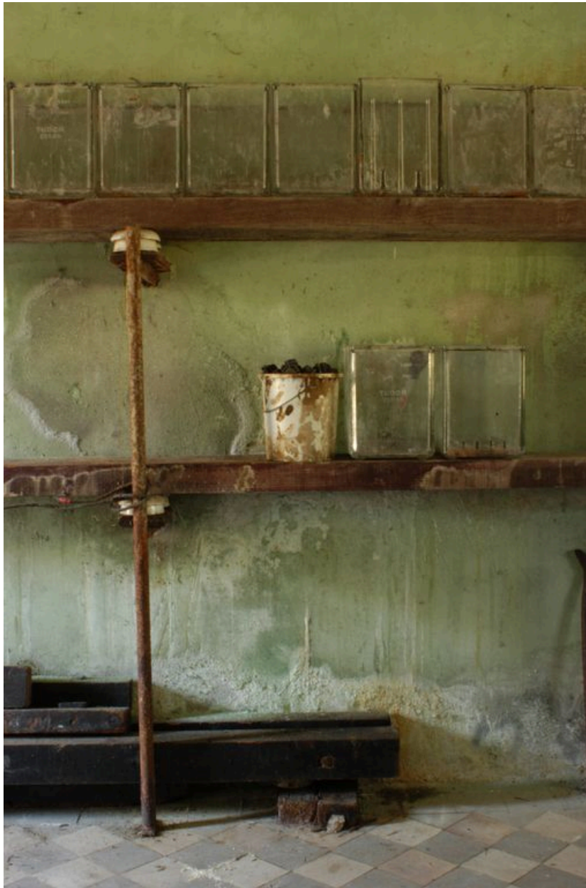
Série de récipients à batteries, mur nord de la la salle des machines.
