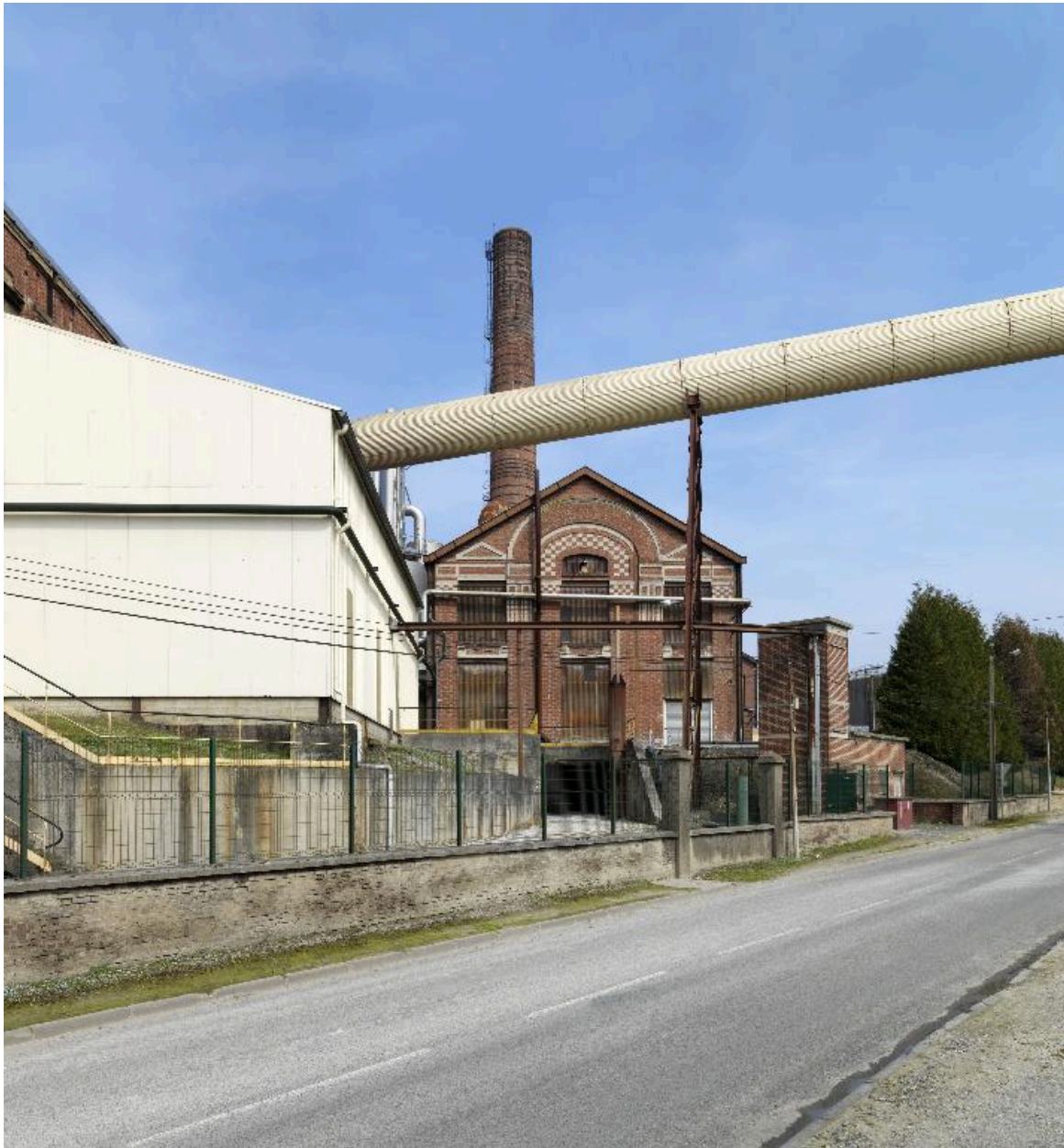
Pignon sud de l'atelier principal de fabrication de la sucrierie
