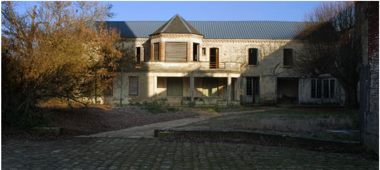
Façade sur cour du logement patronal.
