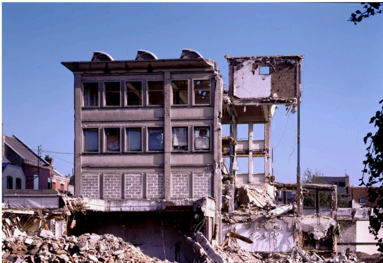
Vue de l'usine en cours de démolition.
