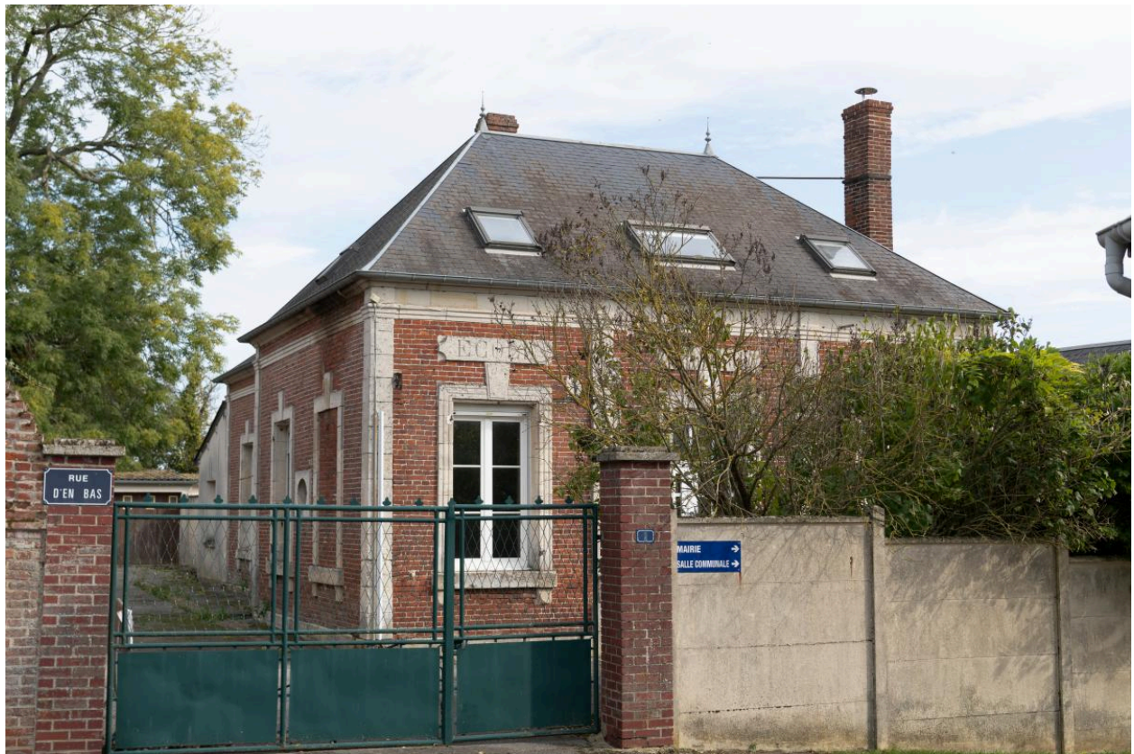
Ancienne mairie-école, vue depuis l'ouest.
