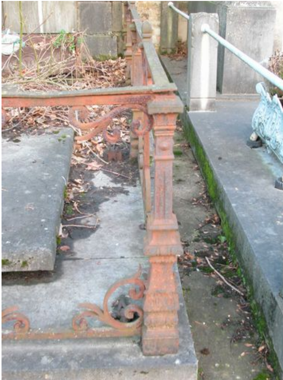
Détail d'un pilier de la grille.
