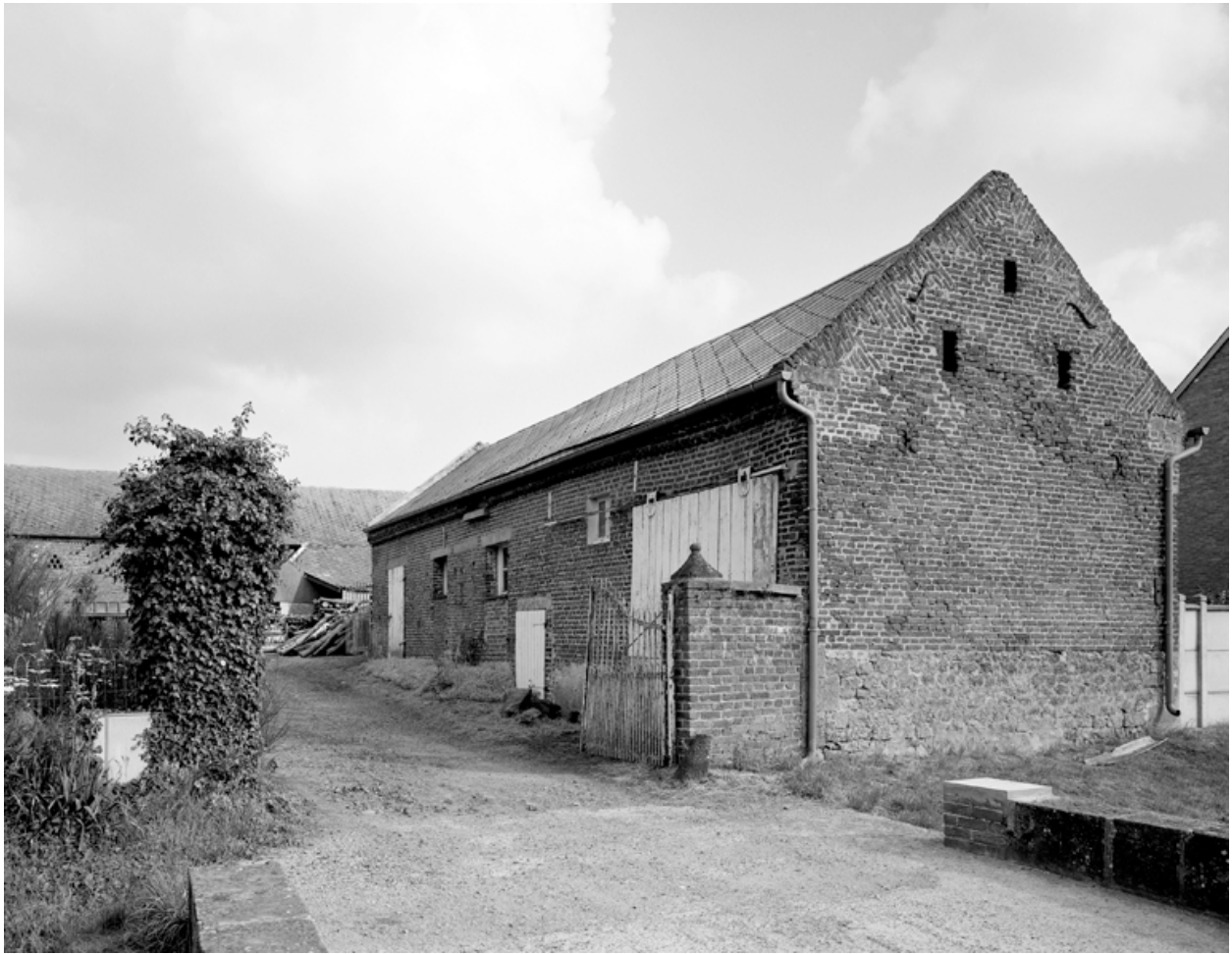
Vue nord-ouest du bâtiment à usage de resserre et laiterie.
