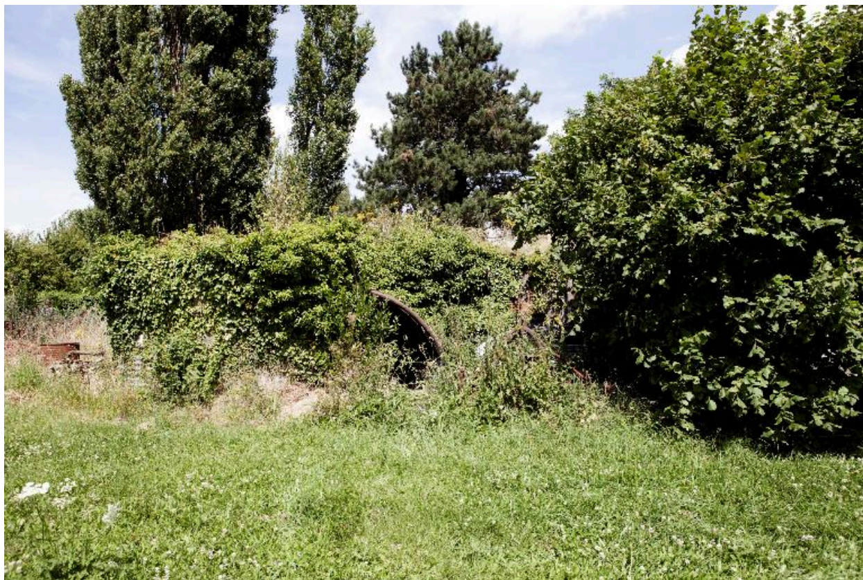
Vue de trois-quarts cers le nord-ouest
