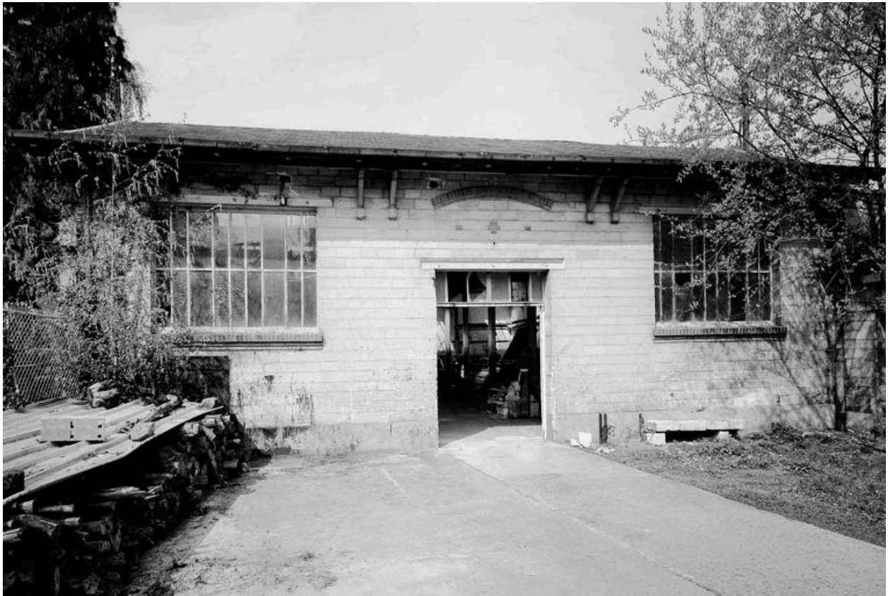
Atelier de fabrication de l'usine de verres optiques : flanc sud.
