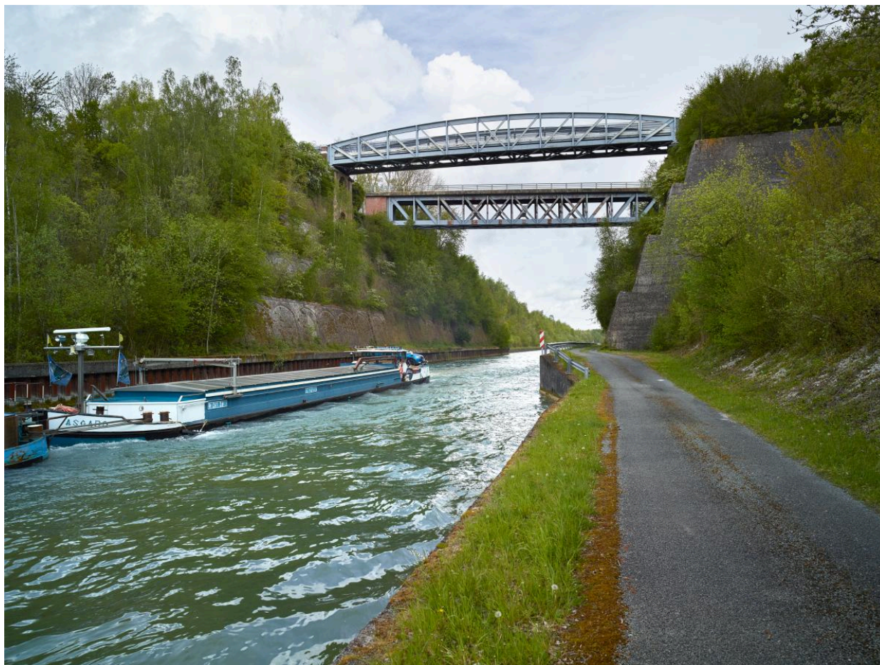
Vue depuis le sud de l'ouvrage.
