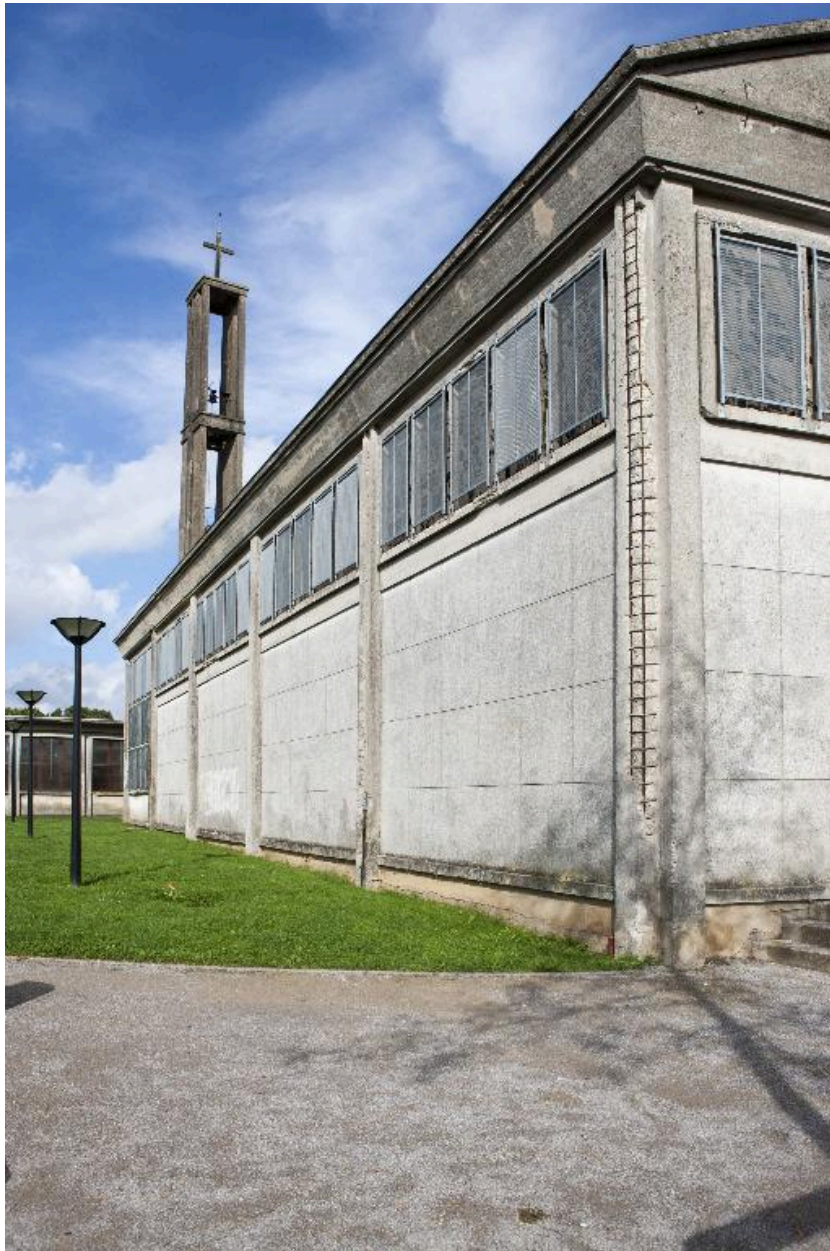
Élévation du flanc gauche de l'église.
