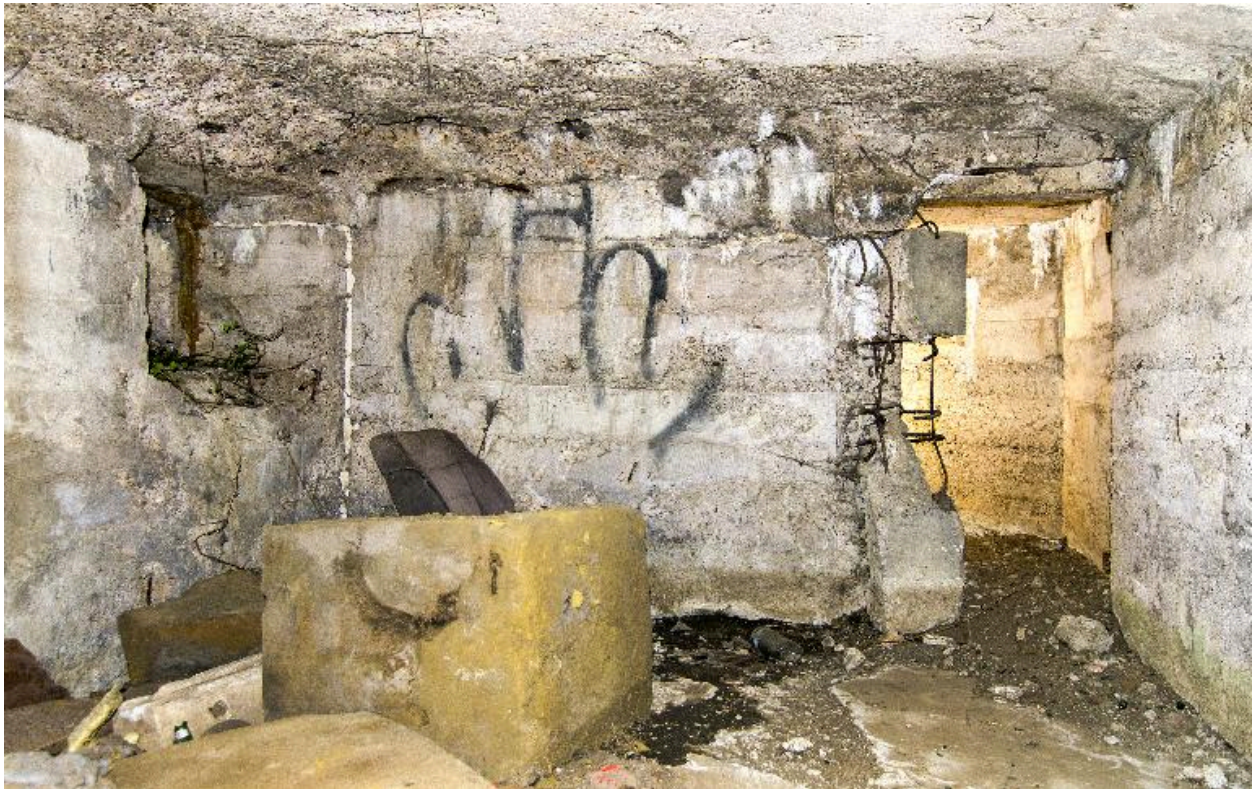
Vue intérieure de la salle sud. Au fond, le couloir en chicane de sortie
