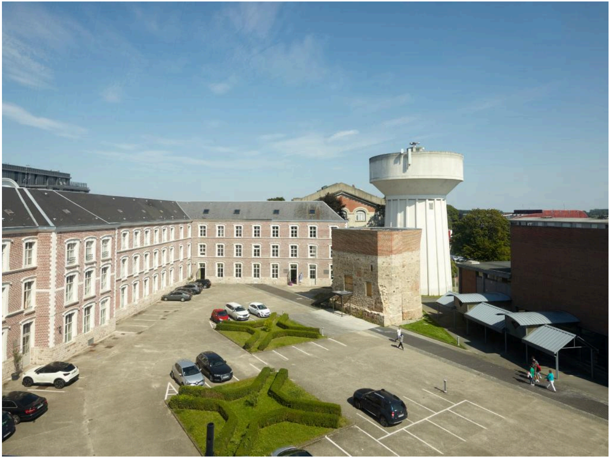
Vue générale du nord-ouest de la tour, prise depuis les étages du lycée.
