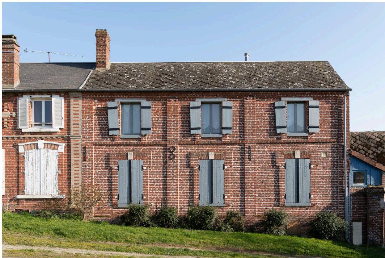
Ancien café, 1871, n°141 de la rue de Clermont, vue prise depuis l'ouest.
