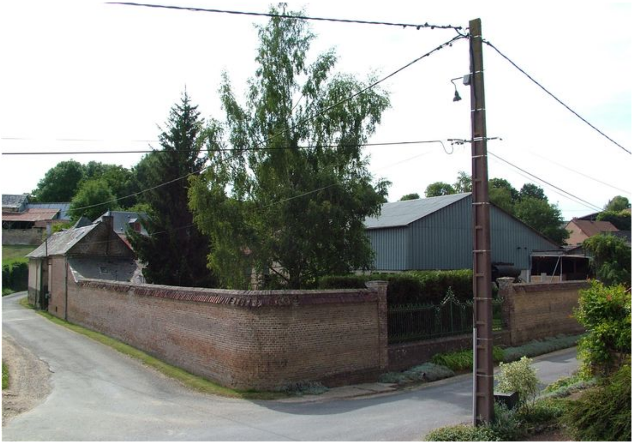
Vue générale extérieure depuis le nord.
