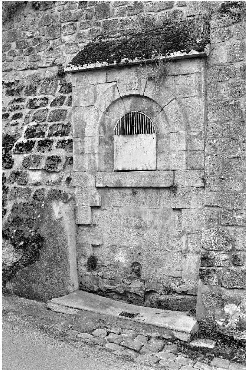
Vue générale du puits.
